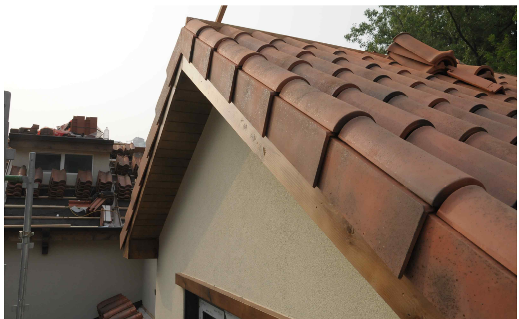
갓기와가 설치된 지붕 형태
