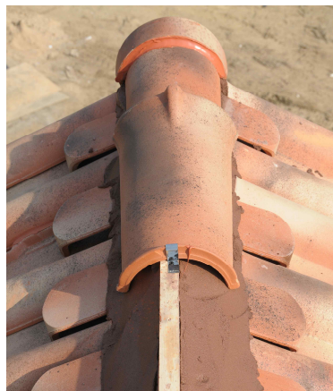
용마루 기와 시공 형태
